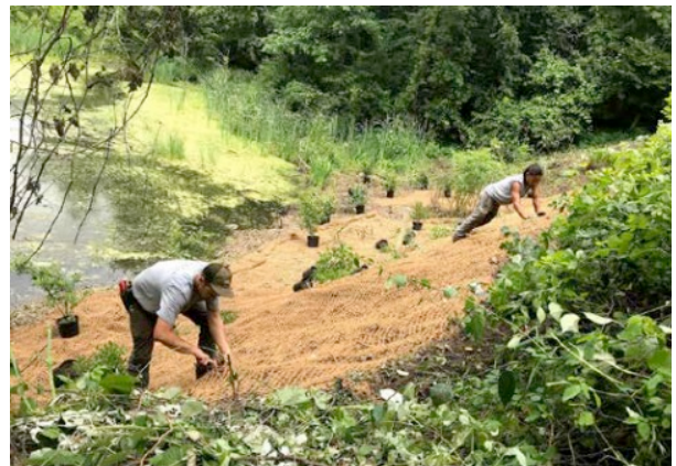
Fixação de redes sobre a encosta e plantação de gramineas autóctones.
