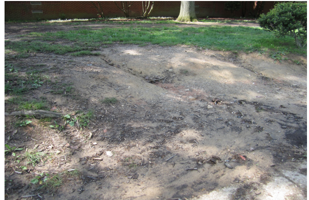
Prova da erosão do solo. É visível o caminho da água marcado no solo.
