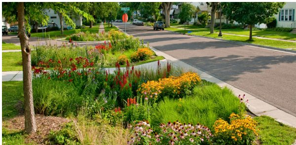
Um jardim de chuva plantado no fundo de um encosta capta a água.
